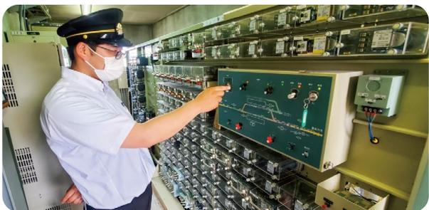
通常時は自動で制御している信号も、今回のような異常時には一つひとつ手動で進路を構成して列車を動かします。
