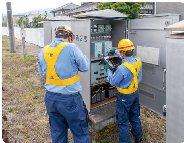
電気区は、変電所や電車線、踏切、信号、通信など、列車の運行に関わるさまざまな電気、電力、信号通信設備の保守・点検をするのが主な業務です。
