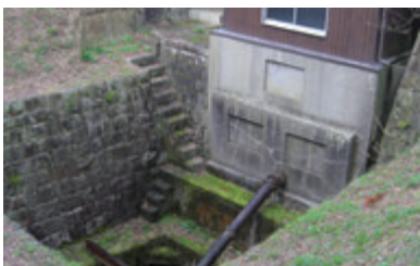
日本で最初の蒸気機関動力ポンプによる灌漑揚水場
