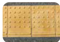
内方線付き点字ブロック
