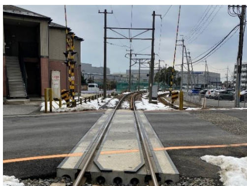
踏切道改修（高宮 1 1 号踏切）
