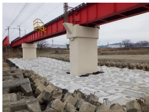
愛知川橋りょう洗堀対策
