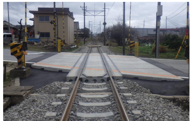
踏切道改修（宮田道踏切）
