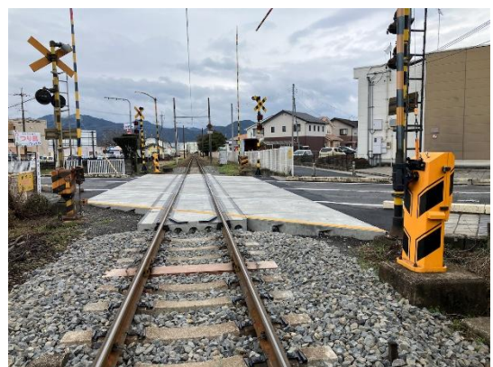
踏切道改修（城南街道踏切）
