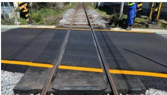
踏切道改修（中野 4 号踏切）
