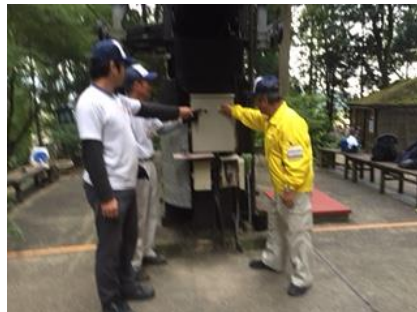
賤ヶ岳(操作盤取扱い研修)
