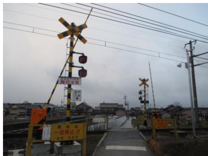
踏切第1種化工事
