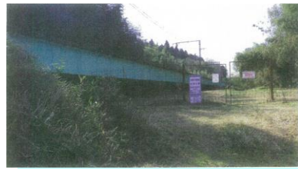
日野川橋梁改修工事
